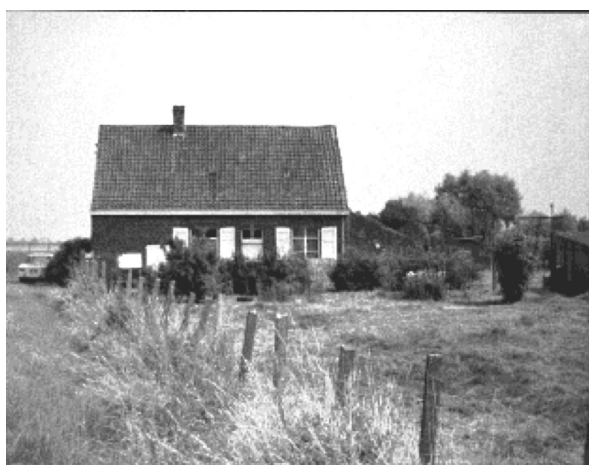
Het boerderijtje van Maurice Haek gelegen aan de Kwakkelweg 1, verdween als laatste voor de aanleg van het industrieterrein.
