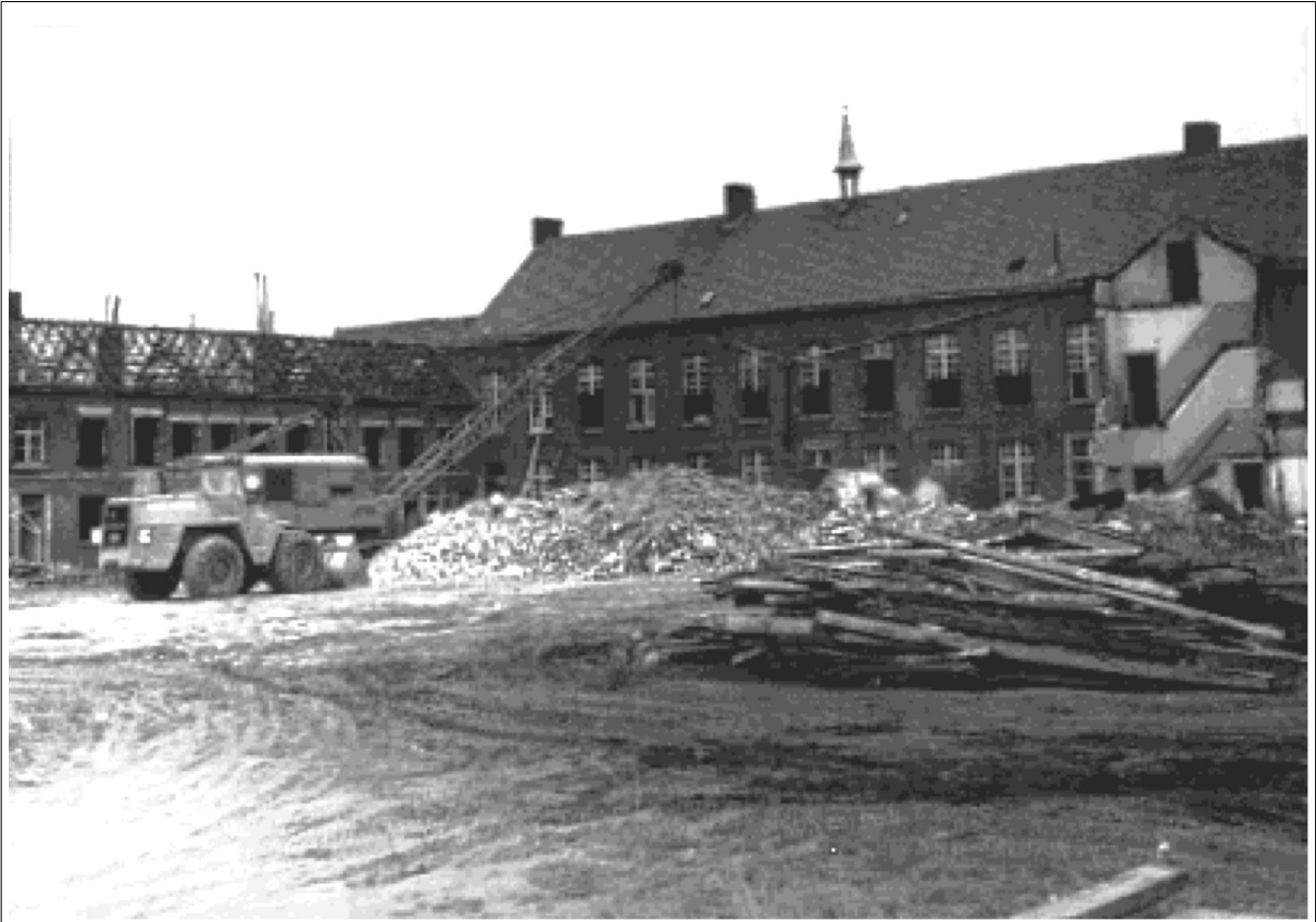
Afbraakwerken aan het oude St-Jozefsrustoord.
