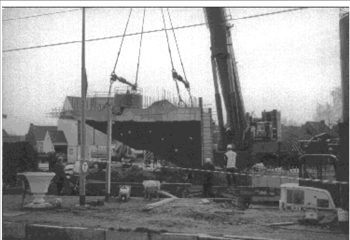
De trapconstructie wordt op haar plaats gemanoeuvreerd.
