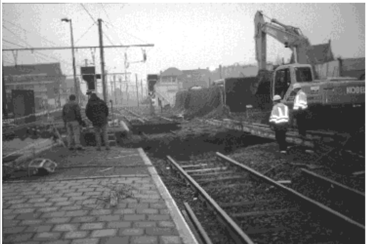
Straks wordt in deze bouwput een tunnelement neergelaten.
